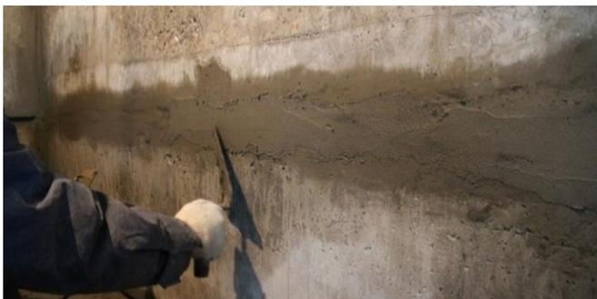
бетона, железобетона и кирпича, разрушенных в результате агрессивного действия воды (дождевых, грунтовых, промышленных). Выдерживает
